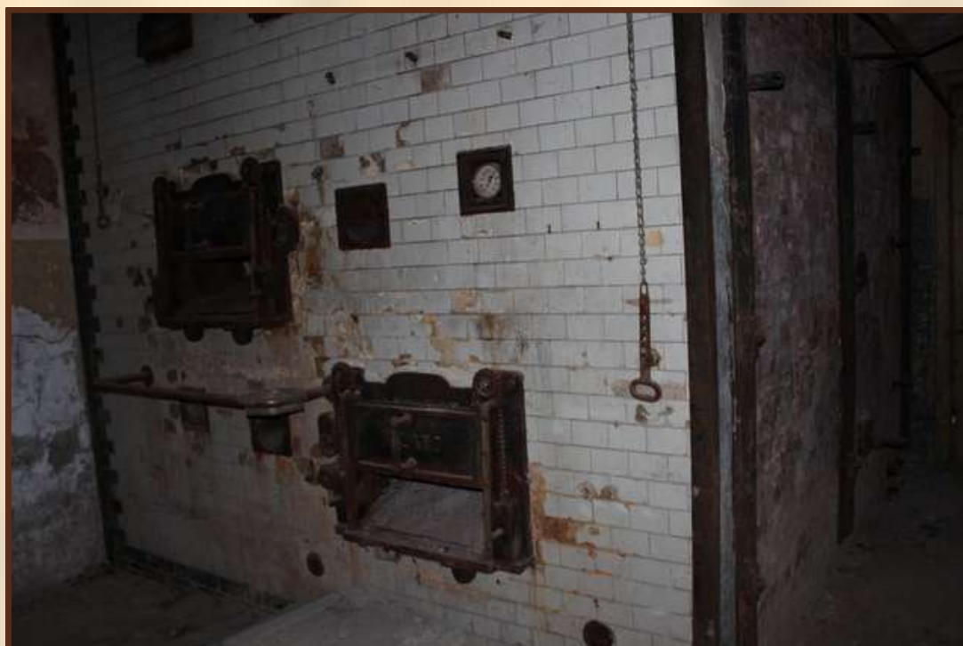
PARNA PEČ PRED OBNOVO, LETA 2020. FOTO: JASNA FAKIN BAJEC.
