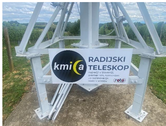
Slika 1: Podnožje največjega radijskega teleskopa v Sloveniji.
