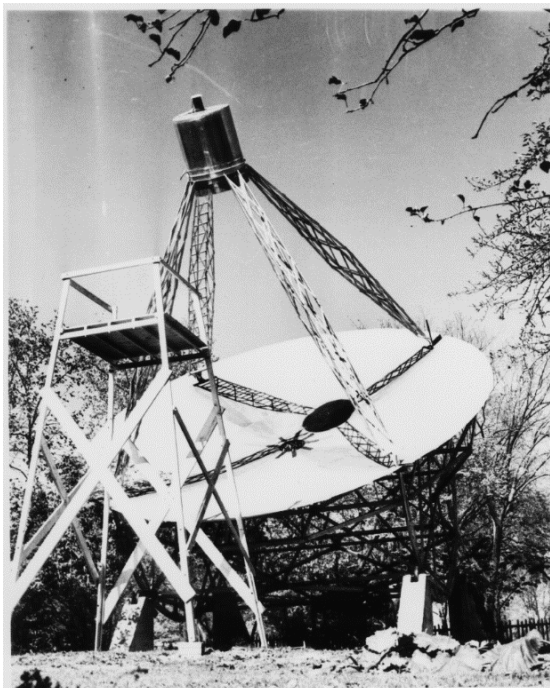
Slika 1: Parabolični reflektor s premerom 9,5 m, ki ga je leta 1937 zgradil Grote Reber v Wheatonu, Illinois, ZDA.
